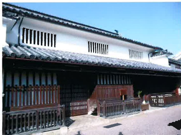
重要伝統的建造物群指定 徳島県美馬市脇町 森家
