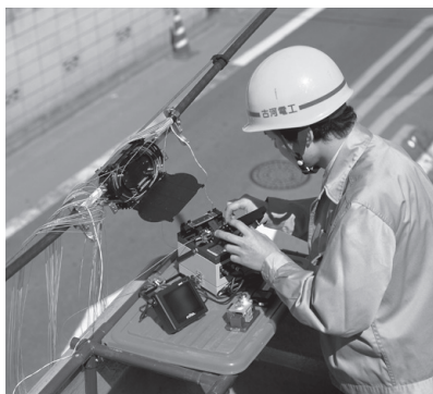
▼写真11 架空での融着接続作業工事例
