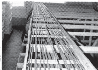
▼写真6b UTPケーブルが平行になっている場合
