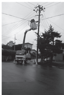
▼写真11 架空での融着接続作業工事例
