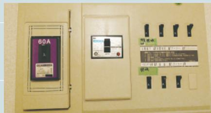
発熱が火災原因となるため安全ブレーカーが設置されています(写真1の右側の部分参照。1つの回路あたり20Aです)。
