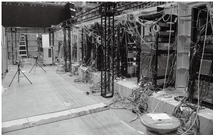
▼写真9 排熱処理は写真右にある送風装置からダクトを伝ってラックの下から送り、上へと逃がす構造
